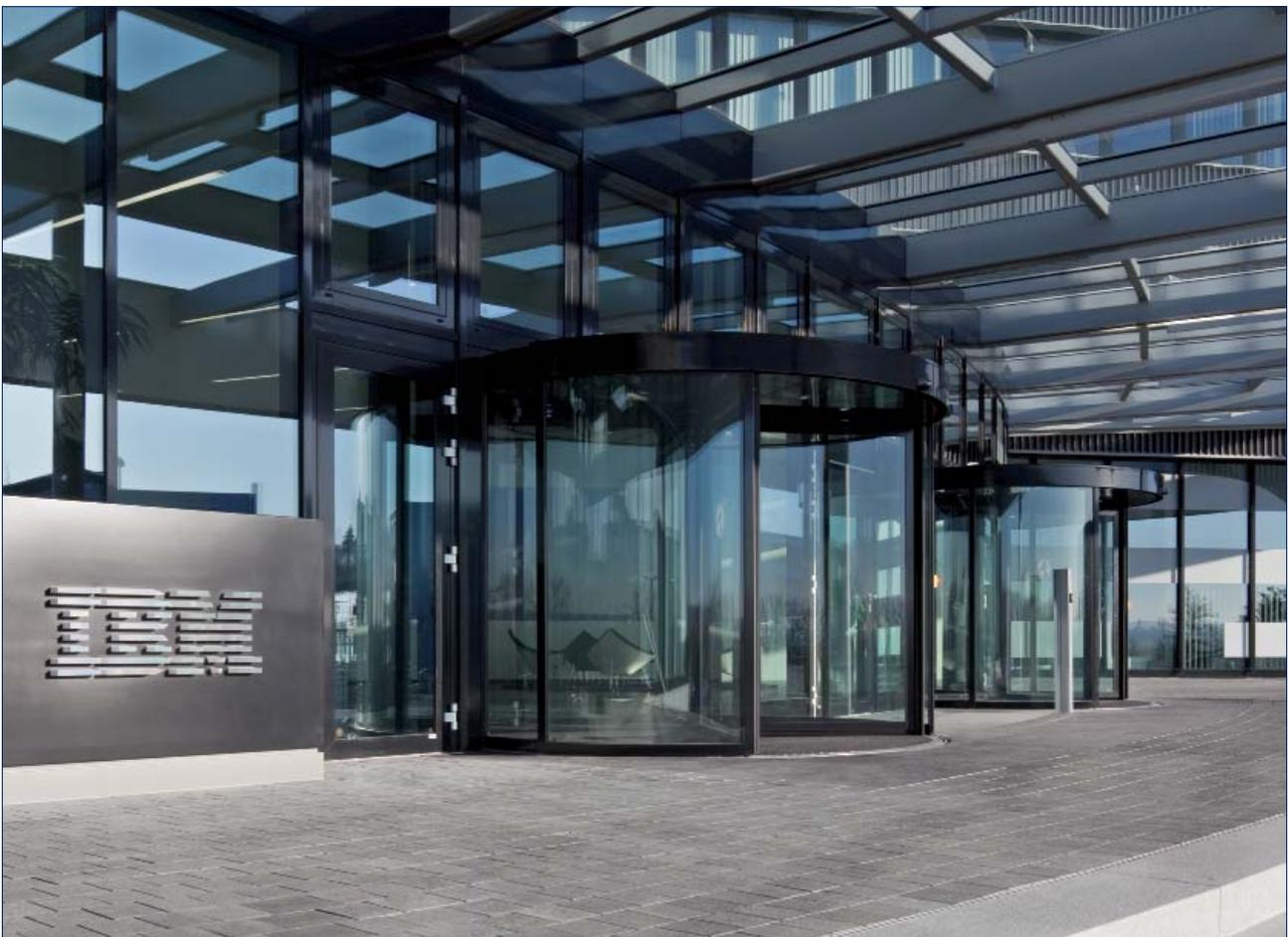
IBM Ehningen - Vollautomatische GEZE Karusselltür mit BO Funktion und automatischem Nachtverschluss, 4-flügelig
