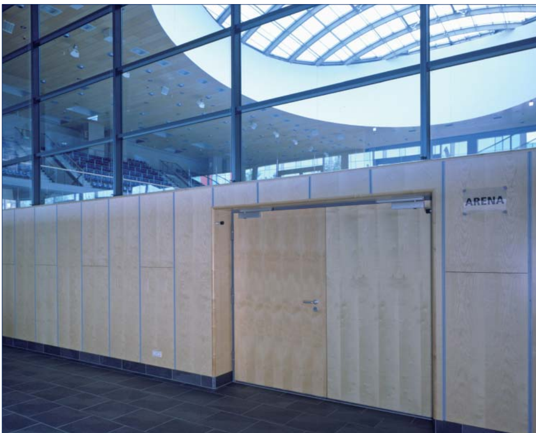
Sportovní hala, Unterschleißheim
